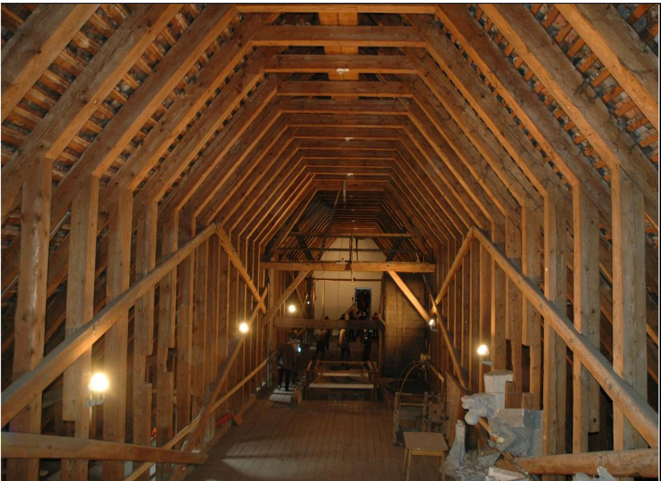
*Konstanz, Münster, Dachwerk über dem Langhaus von 1223-36 bis 1239 (d), Blick nach Osten. Das relativ steile romanische Sparrendach hat senkrechten Sparrenstützen und ist mit angeblatteten diagonalen Streben ausgesteift. Im Hintergrund rechts ist ein erhaltenes Tretrad für den Transport von Baumaterial zu sehen. Foto: Thomas Eißing, 2010.*
